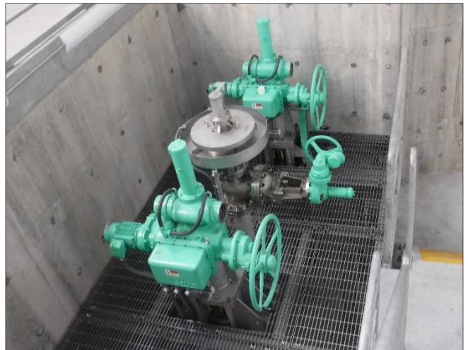
発電建屋(流入水バイパスゲート)
