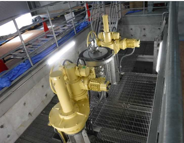
発電建屋(利水放流設備分岐管ゲート)
