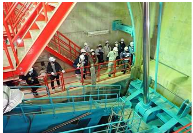
常用洪水吐ゲート設備
