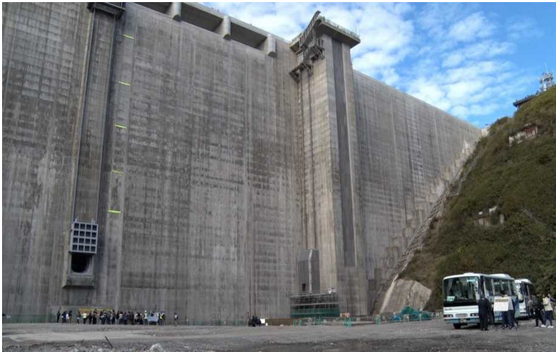
大きい！ 圧巻！ ダムの巨大さに感動！
