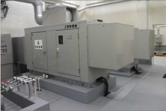
管理棟(予備発電機)
