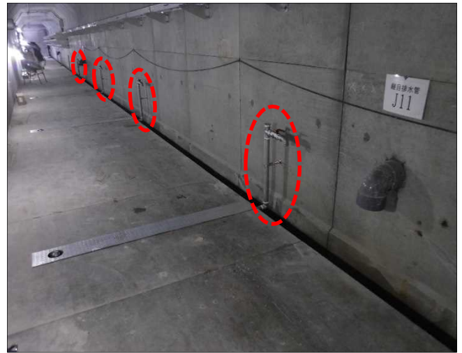
ダム監査廊(堤体観測設備)
