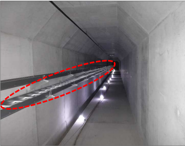
ダム監査廊(ケーブルラック)
