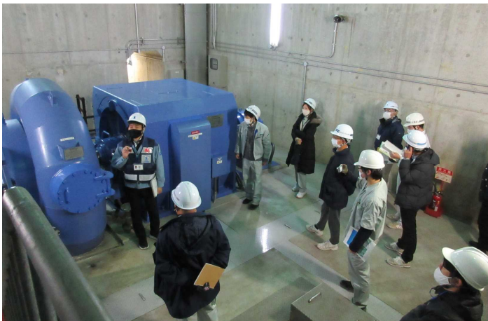
管理用水力発電設備
