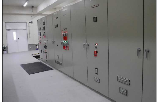
管理棟(受変電設備)
